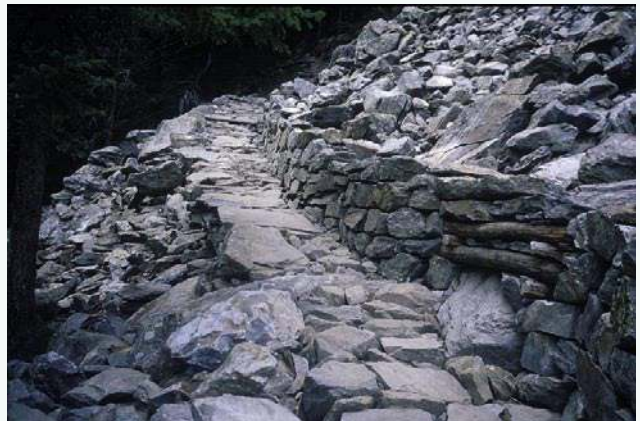
Für die bestmögliche Anpassung an das Gelände kann die Art der Wegbefestigung manchmal auf kurzen Distanzen wechseln.
