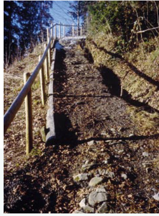
Weg mit bergseitigem Graben zum Ableiten von Hangwässern.
