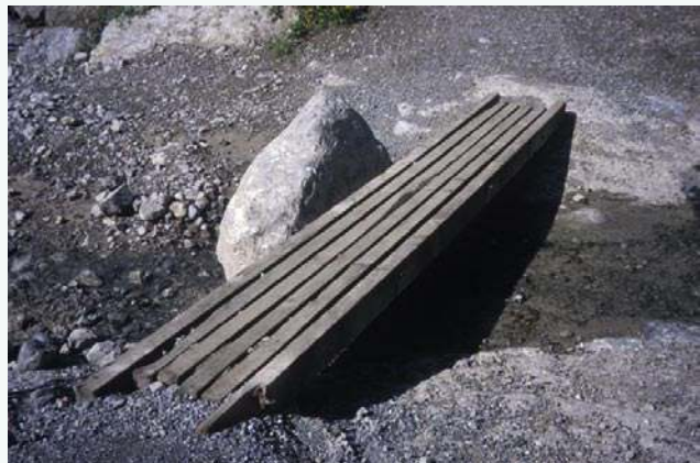
Kleiner Lattensteg, der wegen der wiederholt verstärkten Wasserführung des Wildbachs mit einer Kette befestigt ist.
