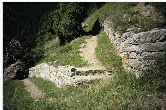
Mit Mauerwerk befestigter Weg
