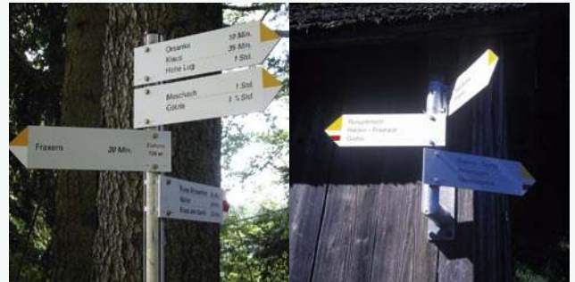
Montage an einem Rohrsteher Wandmontage mit einem Metallbügel
