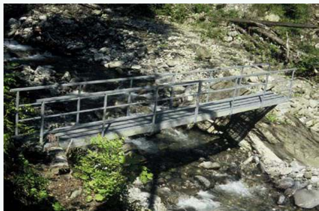
Kleiner Lattensteg, der wegen der wiederholt verstärkten Wasserführung des Wildbachs mit einer Kette befestigt ist.
