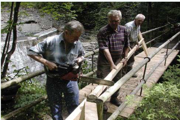
Bei manchen Erneuerungsarbeiten wäre ein Wegwart überfordert, müsste er sie allein durchführen.
