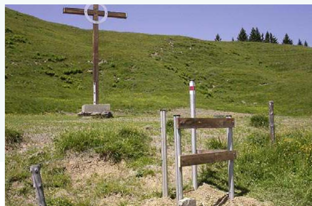
Dreiecksdurchgang mit einbetonierten Alu-Rohren
