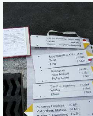
Vorbereitung der Wegweisertafeln für die Montage
