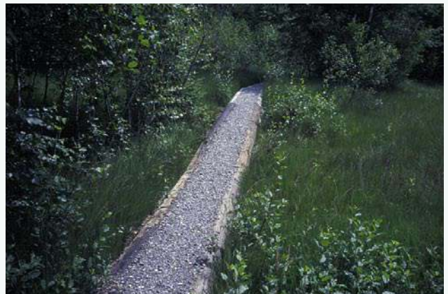
Geschotterter Weg auf Steg aus Rundhölzern.
