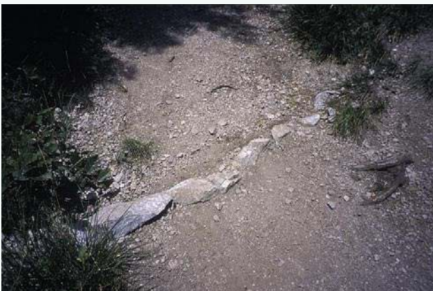
Wasserabschlag mit Steinsetzungen.
