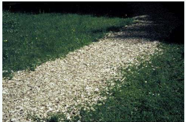
Hackschnitzel-Aufschüttung auf flachem Moorboden.
