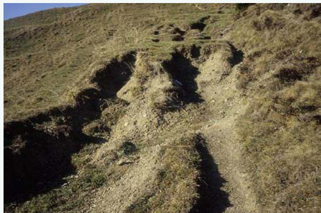
Bei mangelhaften Wasserableitungen können aus Wanderwegen Erosionsfurchen werden, die der Sanierung bedürfen.
