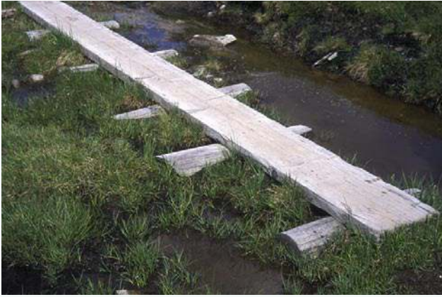
Einfachere Lösungen mit ca. 6 cm starken Lärchenbrettern.
