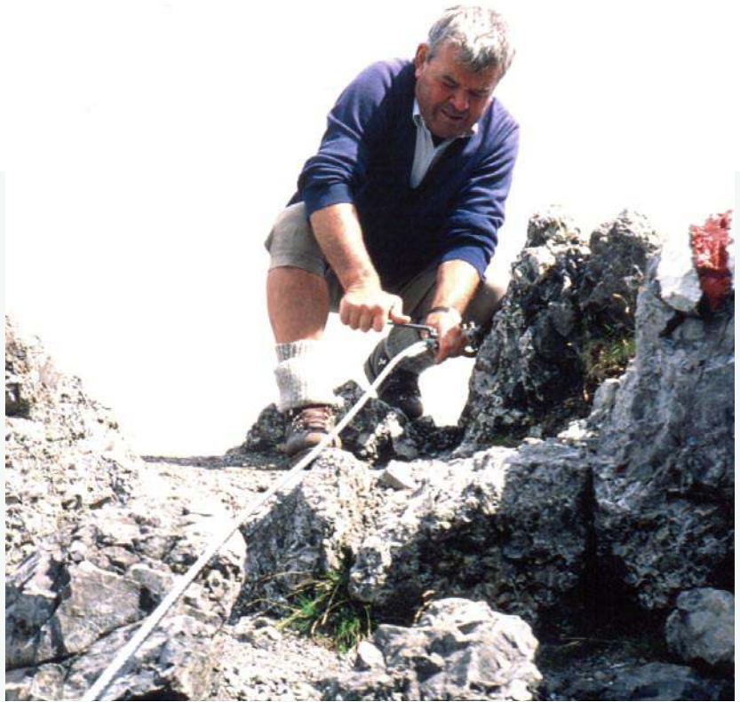
Erneuerung einer Seilsicherung auf einem Felssteig
