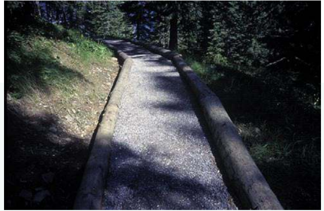
Mit Rundhölzern eingefasster geschotterter Weg auf durchnässtem Boden.
