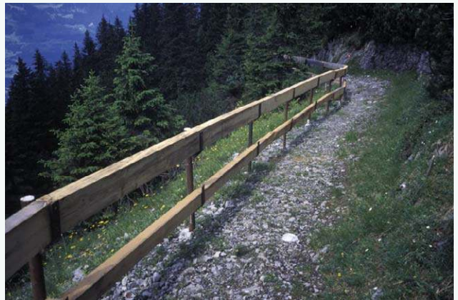
Stabil ausgeführte Holzgeländer
