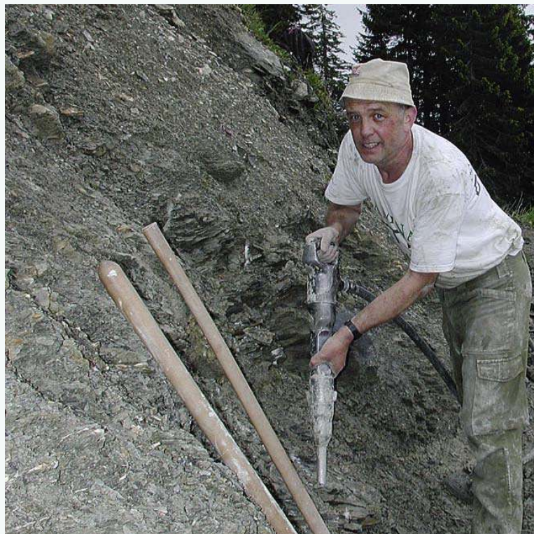
Der Wegebau im Fels kann auch den Einsatz von Pressluftbohrmaschinen notwendig machen.
