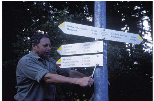
Montage an einem Lichtmast
