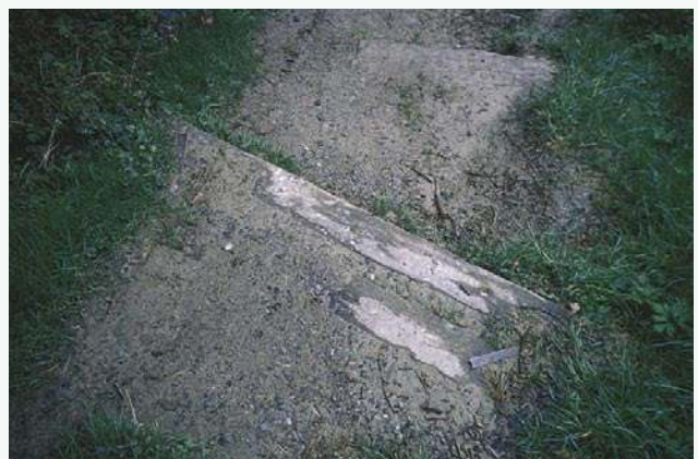
Querrinnen aus Holz, die der wiederholten Reinigung bedürfen.
