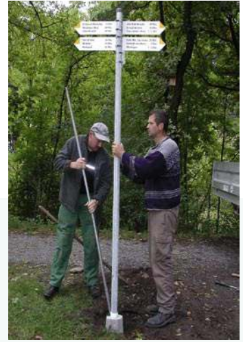
Aufstellen eines Wegweisers mit Fertigfundament
