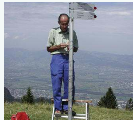
Für die Anbringung der Tafeln empfiehlt sich die Verwendung einer kleinen Leiter oder eines anlehnbaren Podestes aus Leichtmetall.
