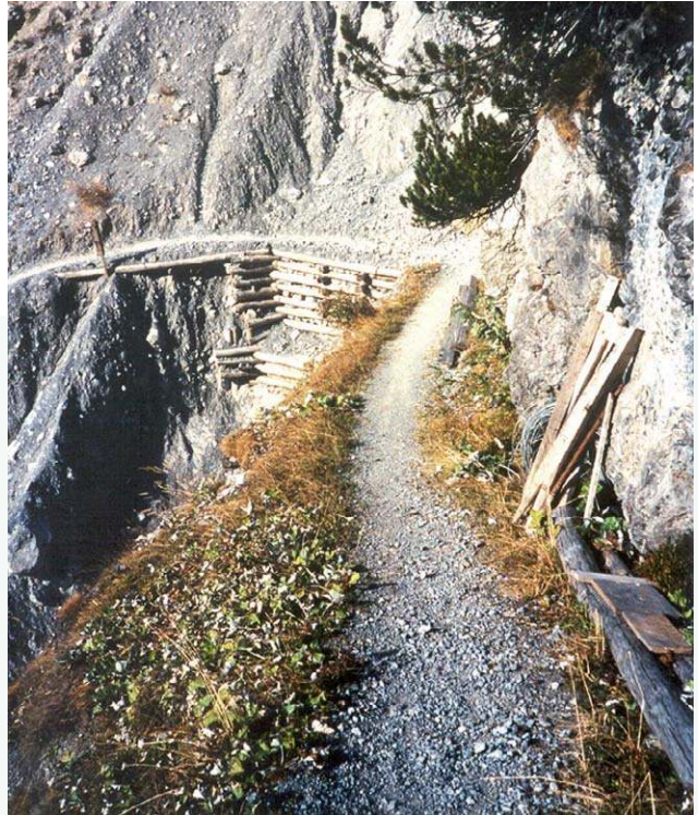
Wegbefestigung in steilen Schutthalden und Wildbachrutschen.
