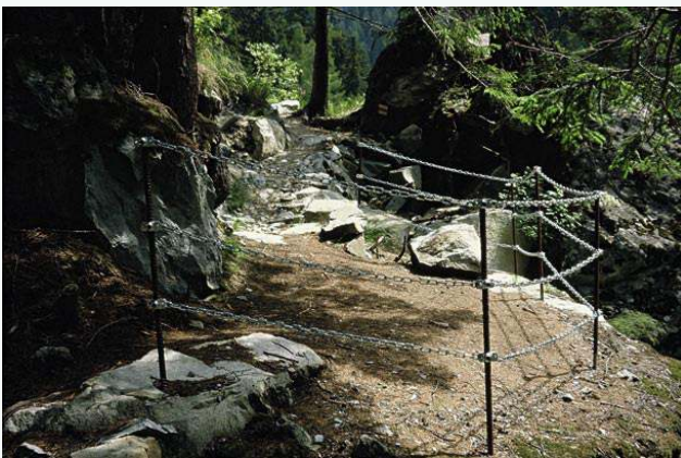
Absicherung mit Pfosten aus Baustahl, oben mit Drahtseil, unten mit dreifach angebrachten Ketten
