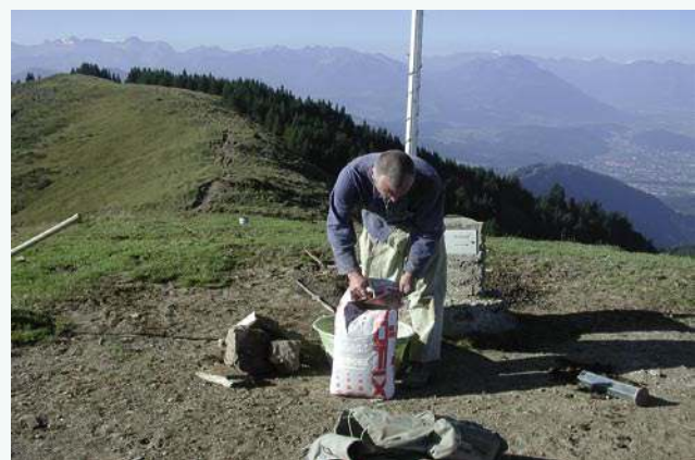
Fundierung am Berg mit Fertigbeton
