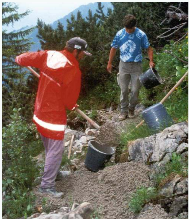
Bei viel begangenen Bergwegen können manchmal aufwändige Sanierungsarbeiten fällig werden.
