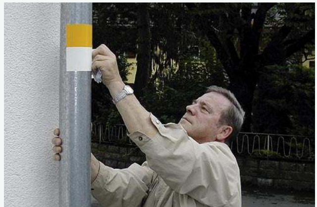
Anbringen einer Markierungsfolie
