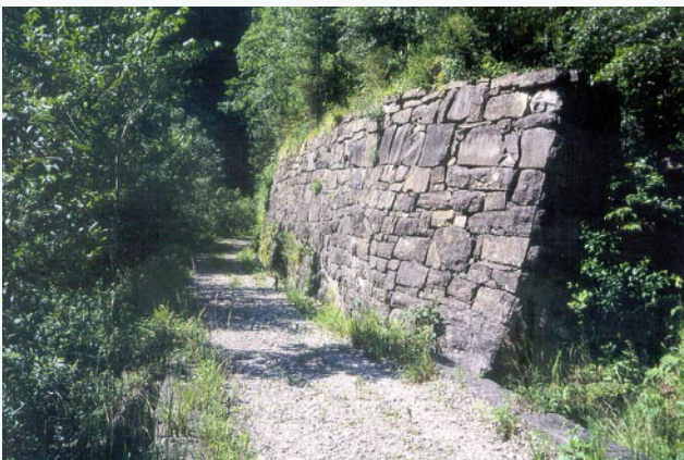
Die aufgelassene Trasse der Bregenzerwaldbahn eignet sich großteils als Wanderweg
