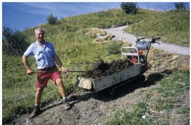
Ausbringen von Humus für die Böschungsbegrünung nach einem Wegebau.
