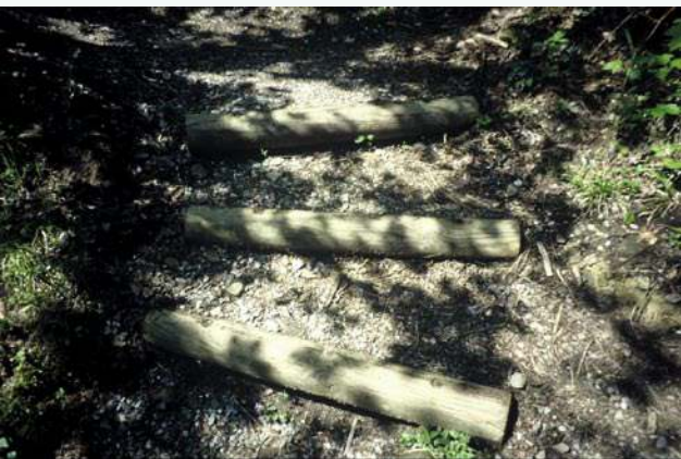
Stufen mit unterschiedlich befestigten Hölzern und geschotterten Tritflächen
